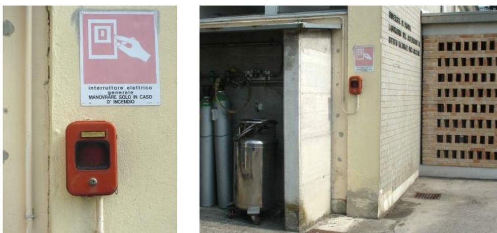
Fig. 2a) Pulsante di sgancio all'esterno dell'edificio CN, che toglie l'alimentazione elettrica in tutto il complesso fabbricati CN (inclusi l'acceleratore stesso, le sue linee di trasporto e gli apparati di misura), e anche Officina Meccanica, Laboratorio di Superconduttività, Laboratorio SPES, Magazzino Biblioteca, Radiobiologia, Amministrazione, Direzione, corridoi Div. Acc. e Div. Tec il 2MeV, Lab Fisica dei Materiali.
